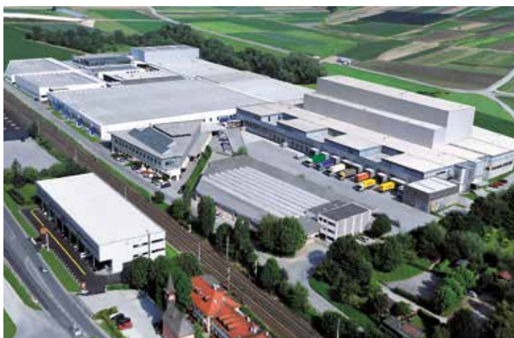
Auf einer Produktionsfläche von rund 90.000 Quadratmetern entwickelt und produziert Felder in Hall, aktuell wird der Standort durch einen Logistikkomplex erweitert.
